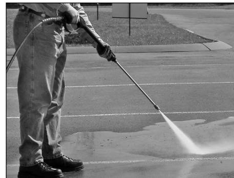
Figura 15 - Mejor ángulo de limpieza de superficies
