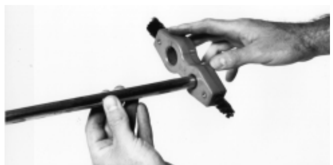
Figure 3 – Nettoyage du tuyau et des raccords en cuivre
